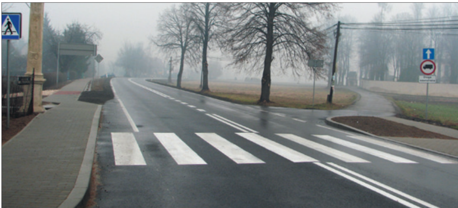
Funkcjonalne skrzyżowanie przy ul. Sobieskiego i Ruchu Oporu
